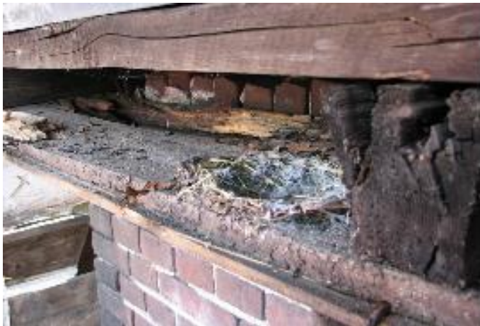
Under renoveringen utanför häckningstiden har ett tornseglarbo hittats i takfot och varsamt bevarats.
