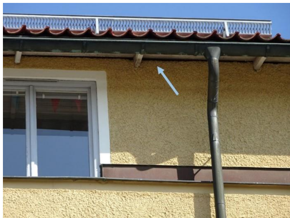
Ingång till boplatser genom luftspalt vid takfoten.
