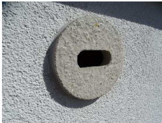
Holksten som passats in i väggen. Färdig putsad syns bara en liten platta med ingångshålet.
