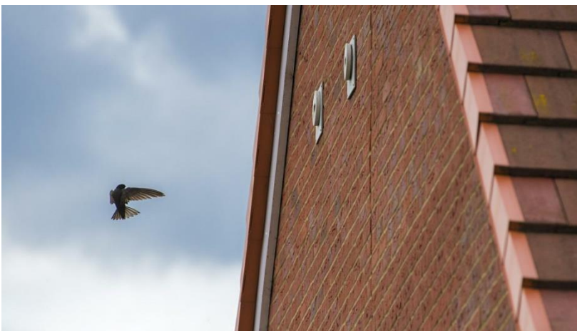
Tornseglare på väg att flyga in till holk som integrerats i husets fasad.
