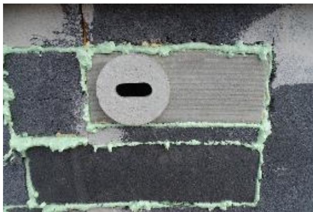
Holksten som passats in i väggen. Färdig putsad syns bara en liten platta med ingångshålet.
