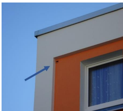
När fasaden är färdig putsad och målad syns bara ingångshålet.
