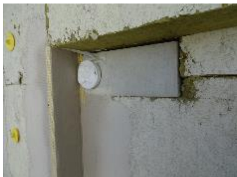
Holksten som passats in i husets isoleringsskikt. Ingångshålet har tillfälligt skyddats med tejp inför putsning av fasaden.
