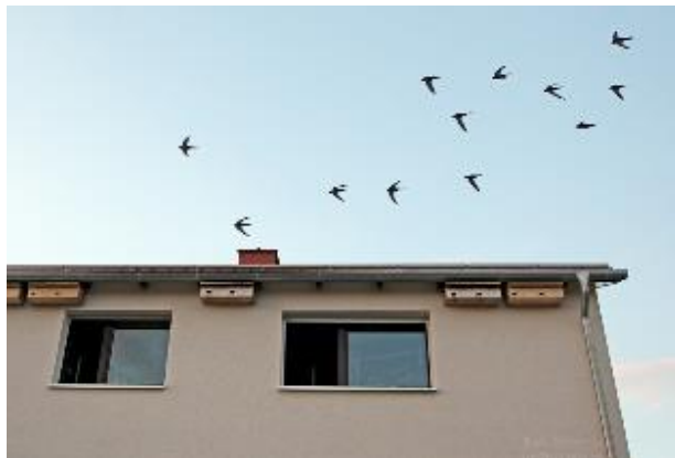
Externa holkar. På ett bostadshus perfekt placerad längst uppe precis under den överhängande takfoten.
