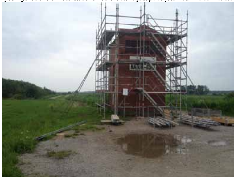
Tysslingen, transformatorstationen då arbetena just påbörjats Foto: Michael Andersson
